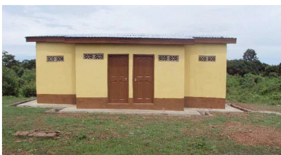
Bloc de latrines
