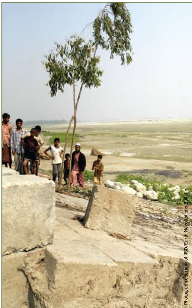
Protection des rives le long de la rivière Brahmapoutre, Bangladesh.
