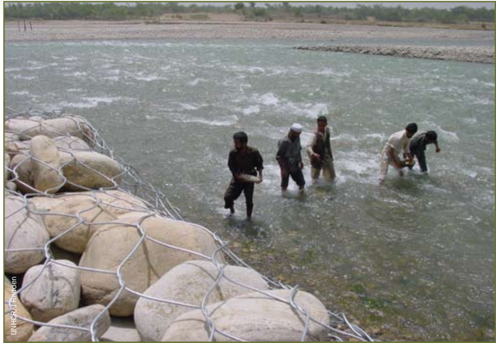
Réfugiés de retour en train de construire des digues contre les inondations à Kalota, province de Kapisa, en bordure de la rivière Panjshir, Afghanistan.
